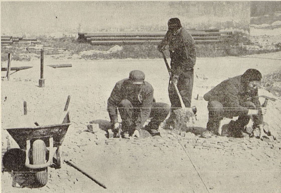
Gradbena skupina pri tlakovanju ceste
