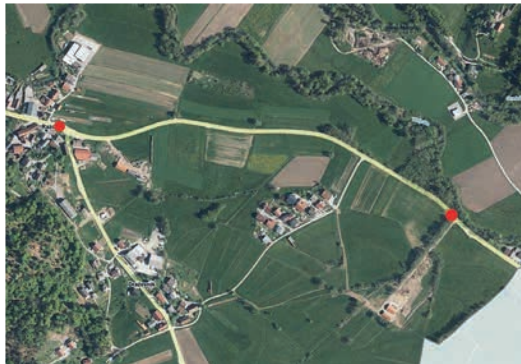
Gradnja trenutno poteka tudi na odseku Dobrova-Razori
