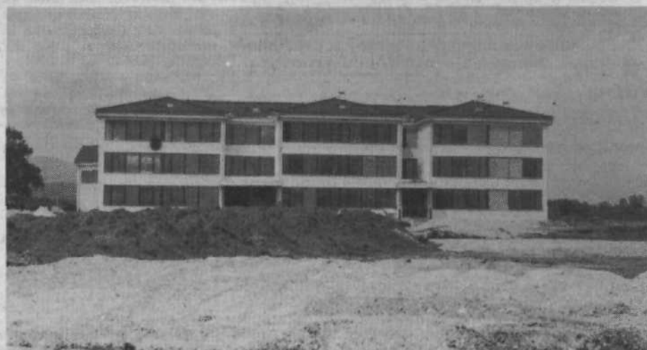
Vzgojni zavod Janeza Levca je že pod streho, zdaj stavbo z veliko naglico opremljajo in urejajo okolico.
