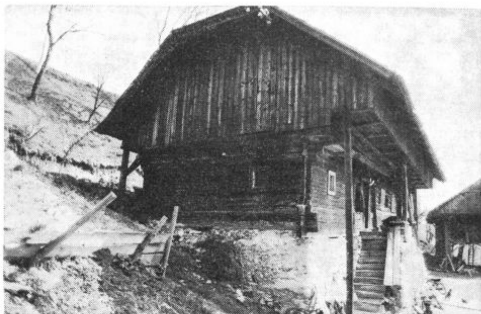
Sl. 4. Jerbolova hiša na Ravnah iz leta 1723. V njeni zunanji podobi in razdelitvi notranjih prostorov so zarisane nekatere tipične poteze kmečkih hiš s hrubovskega obrobja Spodnje Savinjske doline. V njej se je ohranila črna kuhinja do današnjega dne
