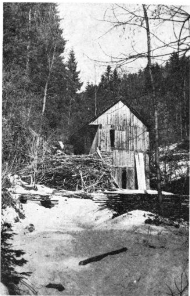
Žaga — Matevž Zazjal. Ena od še stoječih žag, ki jo je gospodar pre- delal na turbinski po- gon (prej vodno kolo)
