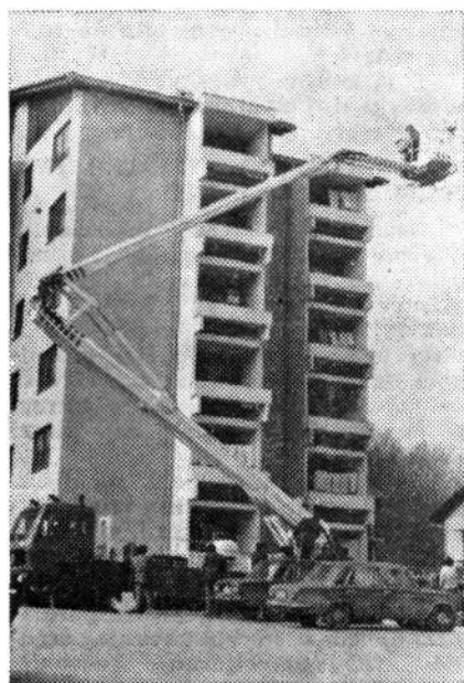
Poklicna gasilska enota Krško pre-more sodobno dvigalo za reševanje iz stolpnic in drugih visokih zgradb.
