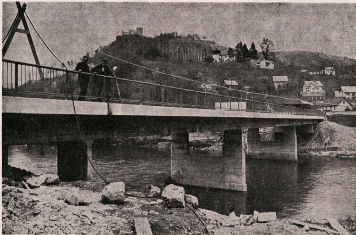
Zadnja dela pred otvoritvijo mostu na Polulah
