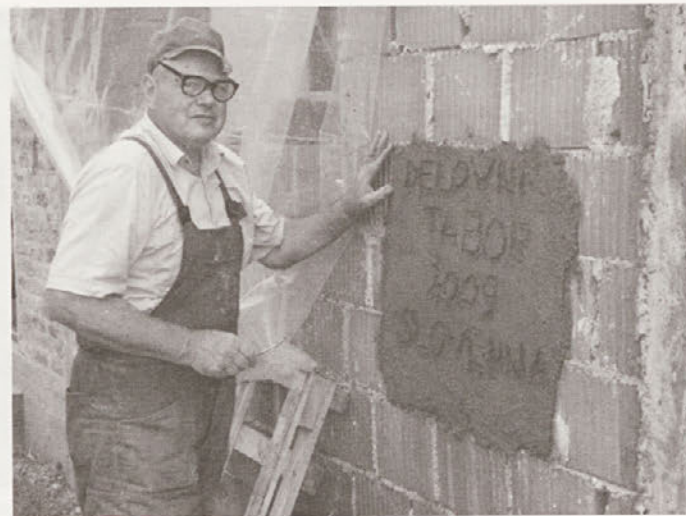
Zidar Mario ob »spominski plošči«. Naj se ve, kdo je postavil prizidek. Foto: arhiv Bogdan Vidmar
