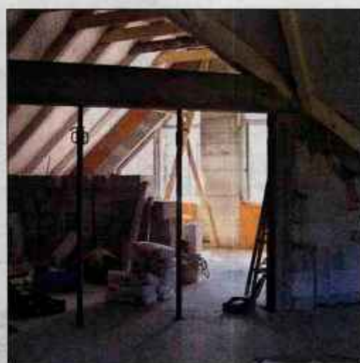
Obnova mansarde v Podružnični šoli Sovodnje.
