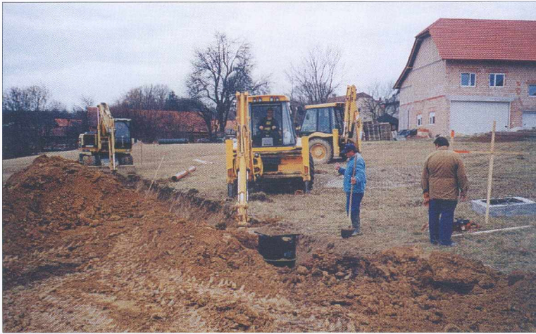
Gradnja kanalizacije Készül a szennyvíz csatorna
