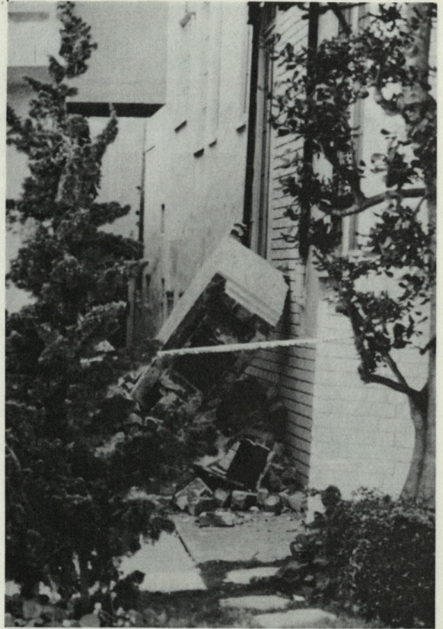
Slika 10: Marina – tipična porušitev opečnega dimnika lesene družinske hiše
