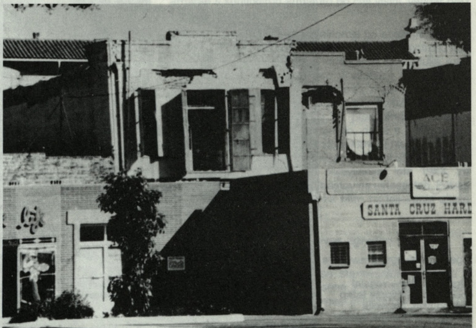
Slika 11: Santa Cruz – med potresom je odpadel zunanji sloj dvoslojnega opečnega zidu
