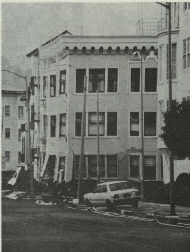
Slika 7: Marina – porušitev trietažne hiše lesene konstrukcije
