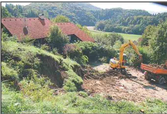
Plaz je zgrmel mimo hiše in pod sabo povsem porušil škarpo nad cesto, ki je vodila k Berločnikovim
