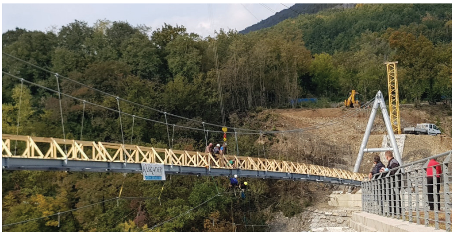
Slika 14. Spajanje posameznih segmentov pohodne konstrukcije in pritrjevanje zavetrovalnih vrvi.
