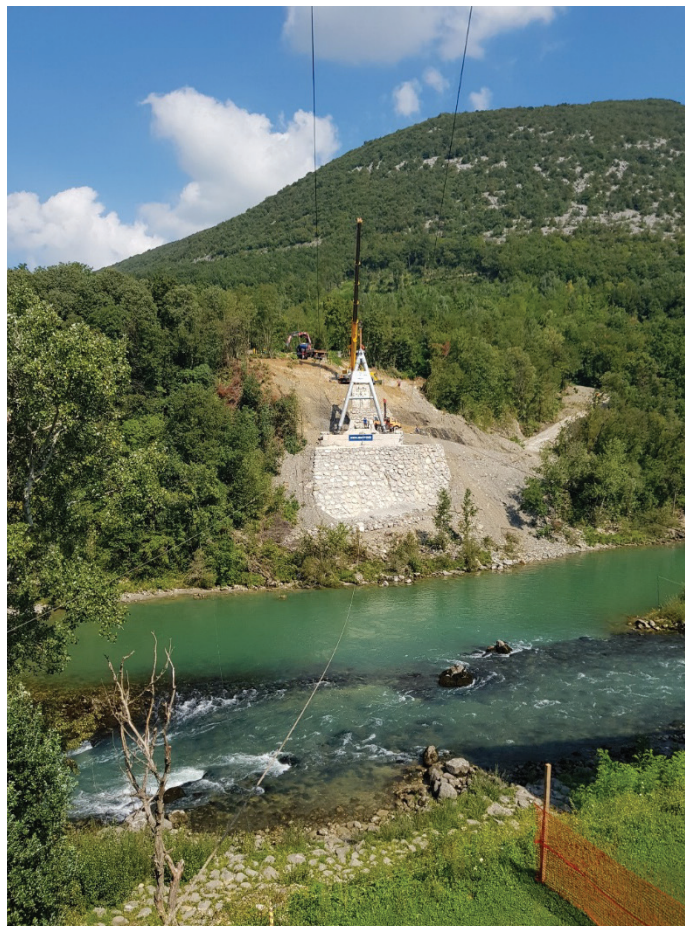
Slika 12. Montaža desnega pilona s pomočjo avtodvigala.
