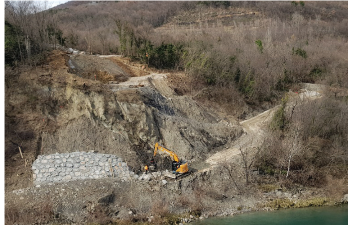
Slika 4. Izdelava obrežne zaščite pred vplivom visokih vod na desni brežini.
