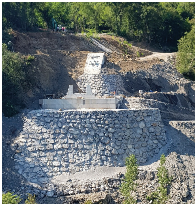
Slika 9. Obrežna zaščita, desni krajni opornik in sidrni blok.
