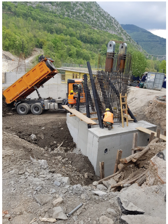
Slika 7. Zasip levega sidrnega bloka. Vidni so nastavki za trajna geološka sidra in vpetje nosilne zaprte jeklene vrvi za levi pylon.
