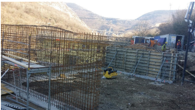
Slika 5. Izdelava levega krajnega opornika in izvedba zasipa s komprimacijo kamnitega materiala.
