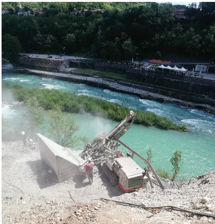
Slika 8. Vrtanje in vgrajevanje trajnih geotehničnih sider na desnem sidrnem bloku.
