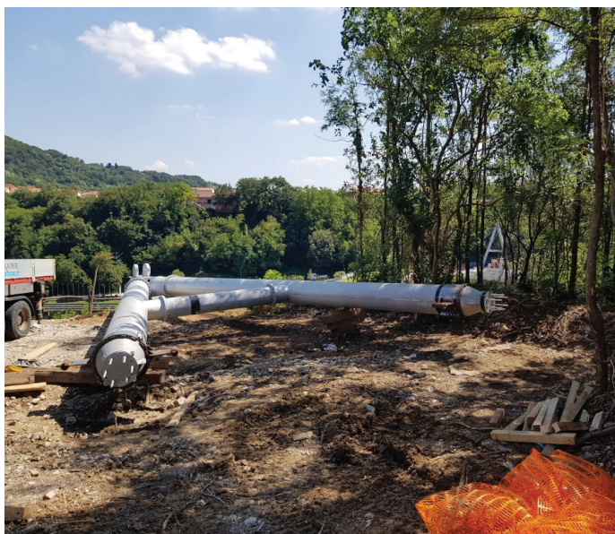
Slika 10. Sestavljeni desni pilon z montiranim ležiščem pred montažo na sidrišče.
