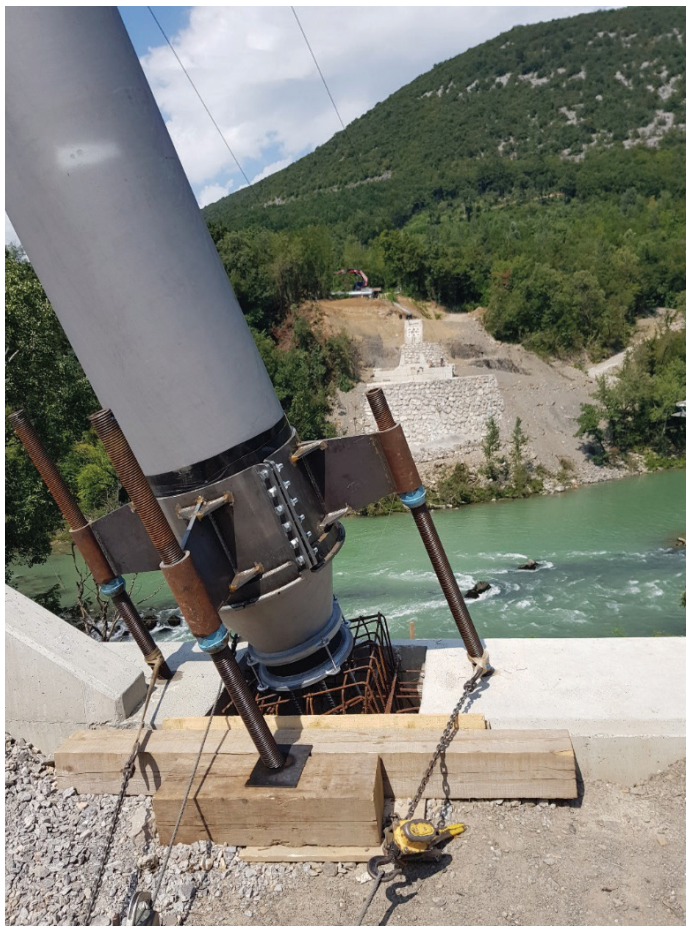
Slika 11. Montirani pilon na sidrišču pred betoniranjem ležišča v krilni zid opornika. Prikazana je začasna podkonstrukcija za milimetrsko natančnost naleganja pilona na ležišče.
