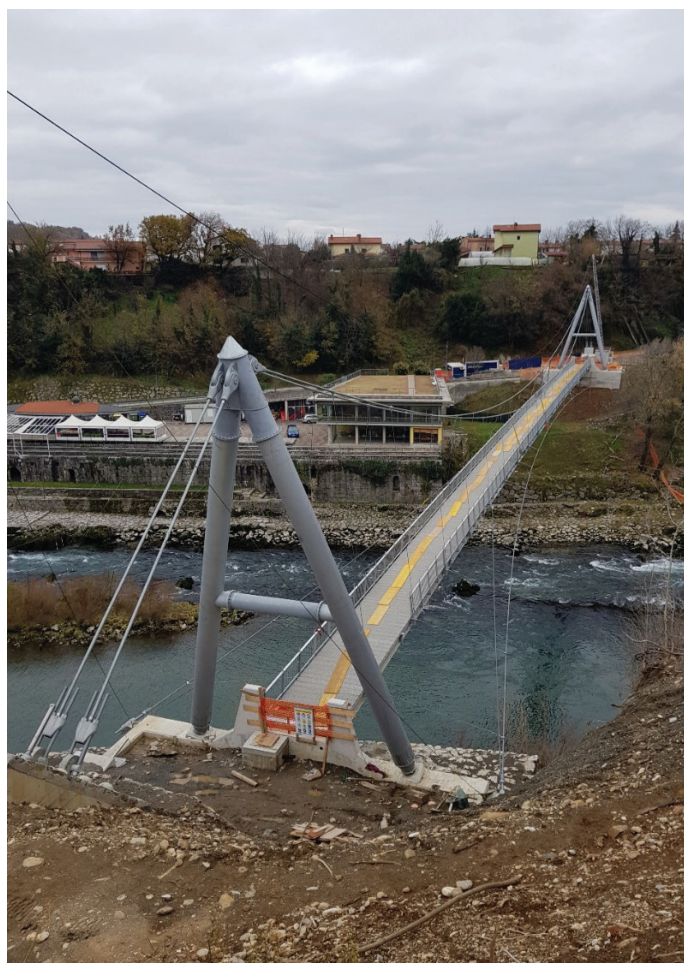
Slika 17. Zaključena montaža brvi in izvedena regulacija loka.
