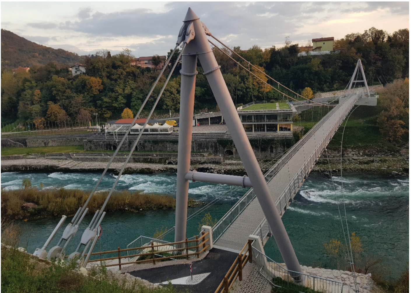
Slika 2. Zaključena montaža brvi.
