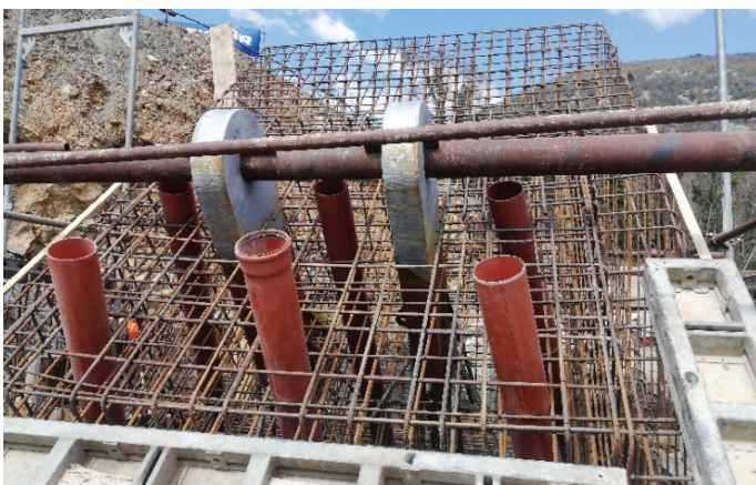
Slika 6. Montaža jeklenih nosilcev za kasnejšo montažo nosilnih vrvi pilona in nastavki smeri za trajna geotehnična sidra na desnem sidrnem bloku.
