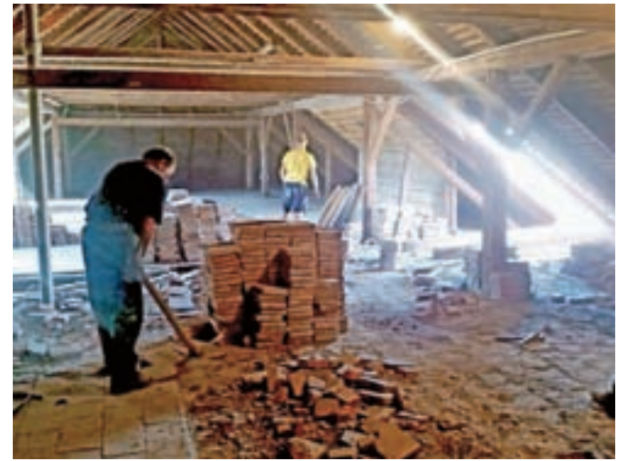
Z ureditvijo mansarde so močno zmanjšali potresno ogroženost stavbe. / FOTO: ARHIV ŠOLE
