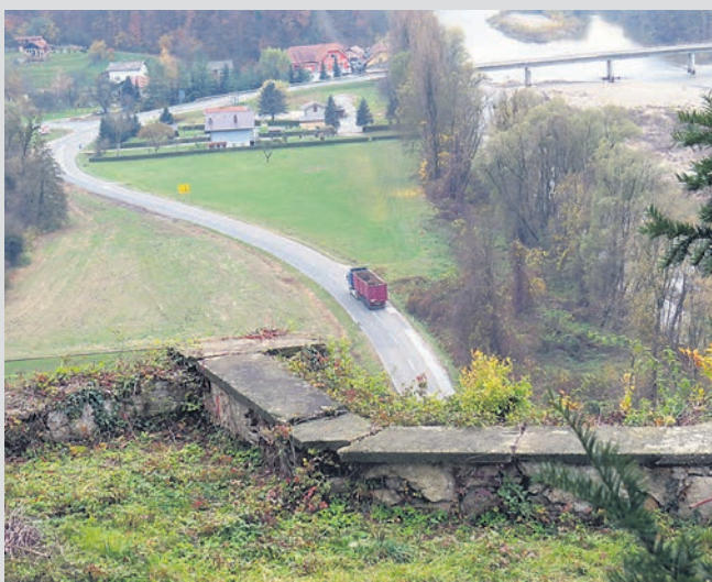
Grad Borl naj bi s sanacijo brežine na mestu terase dobil razgledno ploščad.
