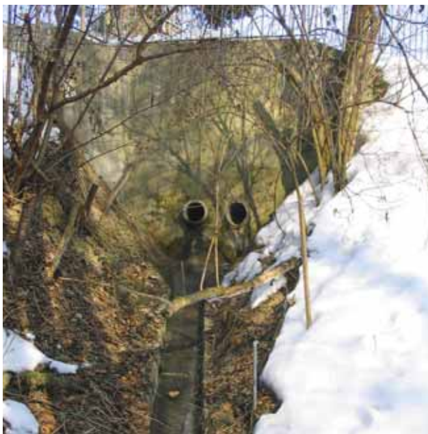
Slika 5 in Slika 6: Primerjava dveh bližnjih meteornih cevi. Cev pod ulico Gača (slika 5) je skoraj suha. Iz meteorne cevi pri "novi" osnovni šoli (slika 6) teče nekaj litrov vode na sekundo (foto: Jure Košutnik).
