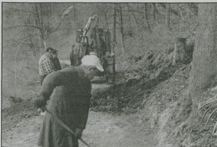
Gasilci imajo že kar domovinsko pravico na "Grajskem drevoredu" in so ga temeljito uredili.
