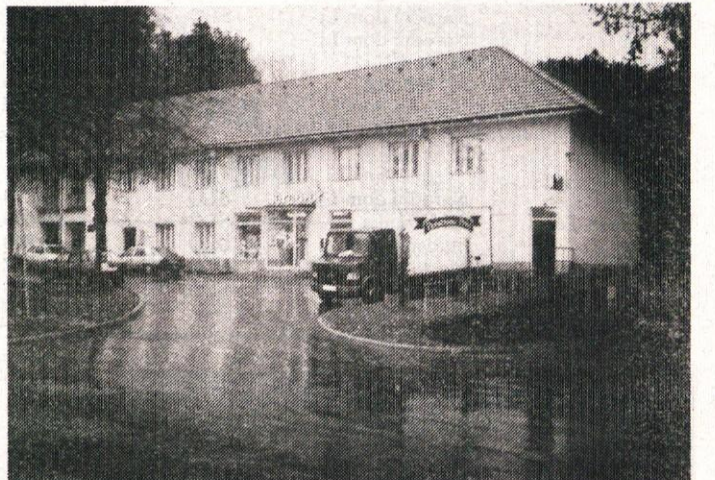
Polovica kulturnega doma v Notranjih Goricah je dobila novo streho in tako z novim ostrešjem pričakuje negotove zimske dni. Obnove so se lotili delavci Krovstva Mihelič, na nekaterih mestih so morali zamenjati dotrajan les, namestiti so nove žlebove in zamenjali vso strešno opeko. Sredstva v višini 1.500.000 so se nabrala iz najemnin, upati pa je, da bo nekaj prispeval tudi občinski proračun iz kulturne dejavnosti. Prihodnje leto bo zamenjana opeka tudi nad dvorano, če bodo sredstva dopuščala, pa se bo obnovil še kakšen del.
