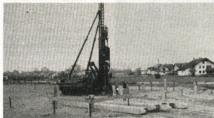
Slika prikazuje gradbišče ob industrijski conina Vrhniki, kjer se pričela dela za izgradnjo nove šole. Najprej je bil napravljen nosilni nasip, ki je »sameval« več mesecev, da se je teren za nadaljnjo izgradnjo nekako »uležal«. V jesenskih mesecih pa je ta prostor za izgradnjo nove šole postal že pravo gradbišče. Začeli so se zabijati betonski piloti, ki naj bi nosili temelje nove šole. Teh pilotov bo preko sto in hrušč stroja za zabijanje se širi kar daleč.
