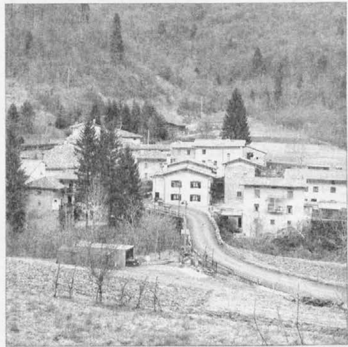
Peternel, nel comune di Drenchia
