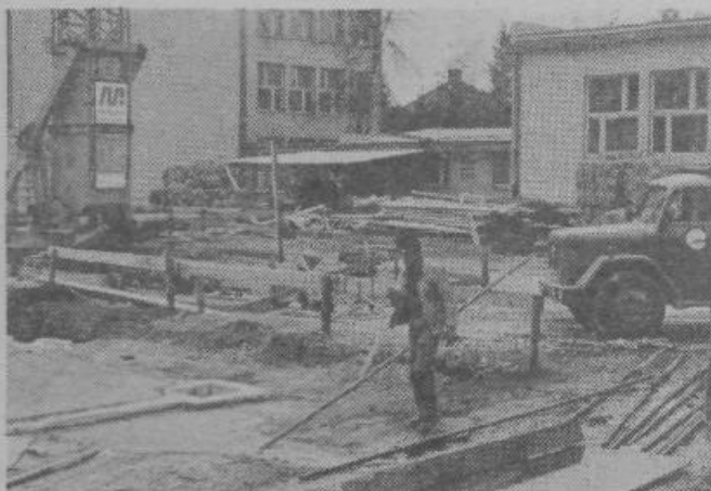
Kot več šol v Ljubljani, bo tudi OŠ Ketteja in Murna na Kodeljevem dobila nov prizidek s telovadnico. Zgrajen naj bi bil do junija prihodnjega leta — tako so povedali v pisarni SGP Graditelj. Sredstva za ta objekt so zagotovljena v programu III. samoprispevka. Na sliki: Dela na prizidku so že v polnem teku
