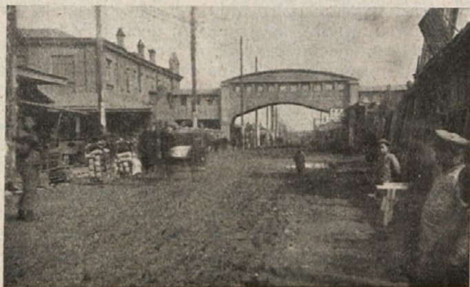
Bolnica v Harbinu s hodnikom preko ceste, ki je zdaj porušen.
