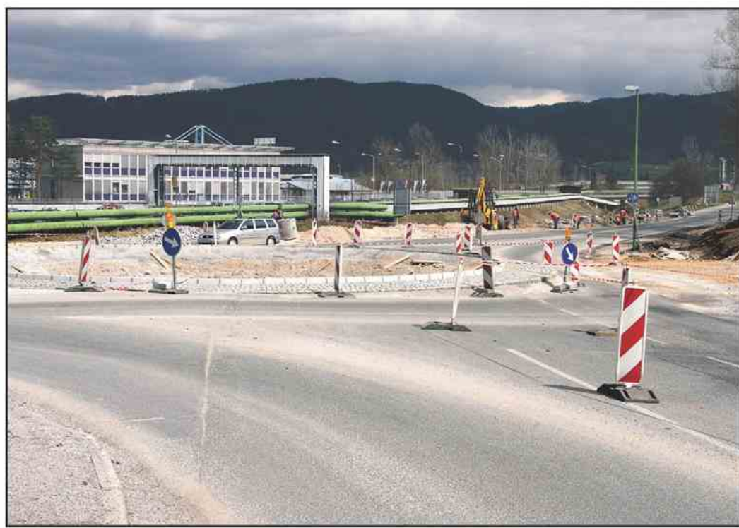
Promet že teče krožno, gradbinci pa hitijo z urejanjem cestišča. Napovedujejo, da bo krožišče končano do 15. maja.
