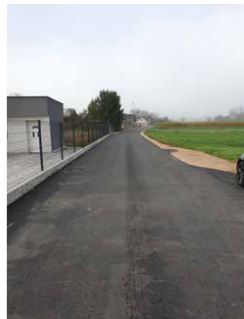
Prenova ceste v Brestu
