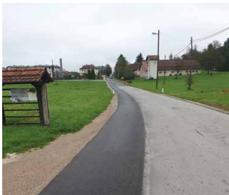
Po obnovi vodovoda
