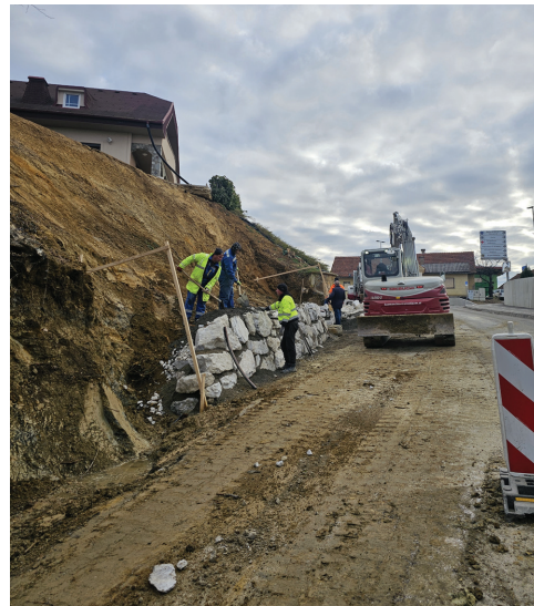
Izgradnja opornega zidu
