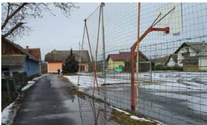
Uničeno postajališče in ograja okoli asfaltnega igrišča.
