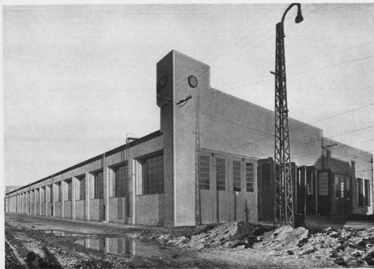
Zgradba Remise Električnih cestnih železnic v Ljubljani Izolacije stropa iz Heraklitha. Upotreba 1.500 m 2 ploča
