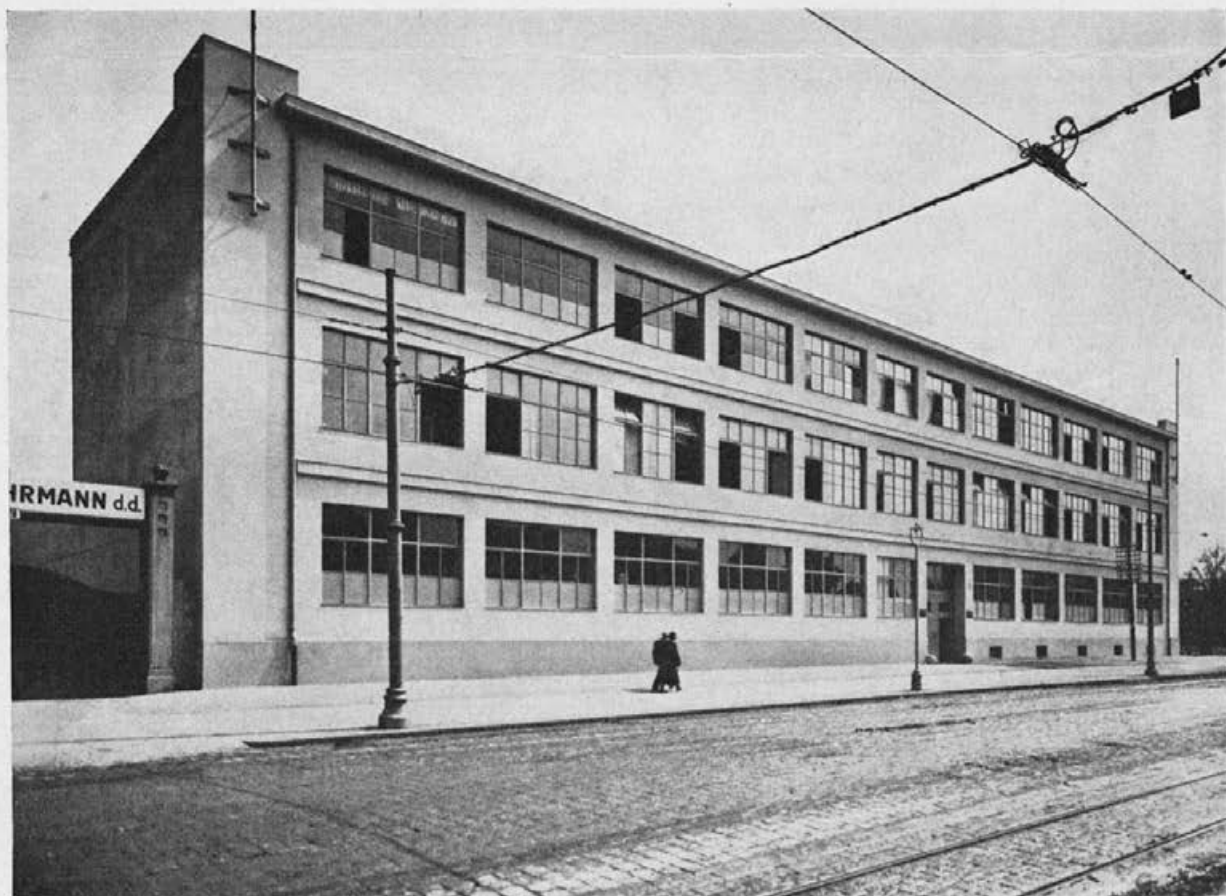
Tvornica „Karton“ d. d. Zagreb Savska c. Izolacija betona Heraklith pločama deblj. 2.5 cm
