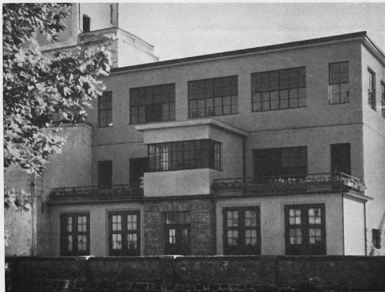
Stanica za električni rasklopni uređaj
