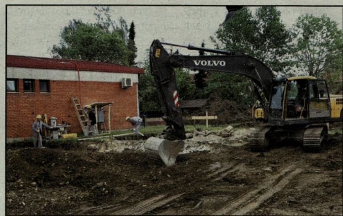
Začetek gradnje prizidka k vrtcu na Polzeli
