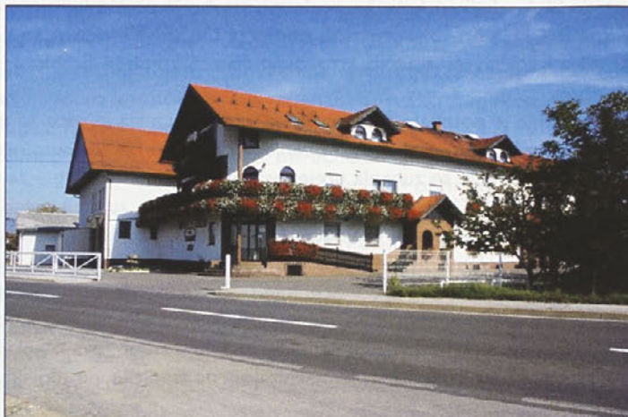
Poslovno-stanovanjski objekt – g. Jožef Figuš – Gaj pri Pragerskem
