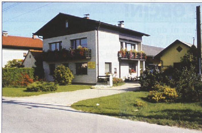
Poslovno-stanovanjski objekt – ga. Milica Kacijan - Stražgonjca Foto: Š. Trčko
