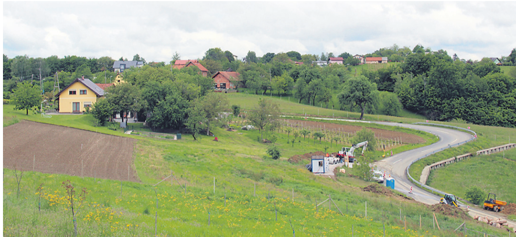
Pogled na posestvo Cvetkovih; meteorna voda z lokalne ceste na zgornjem delu pobočja se steka po pobočju navzdol in povzroča erozijo.
