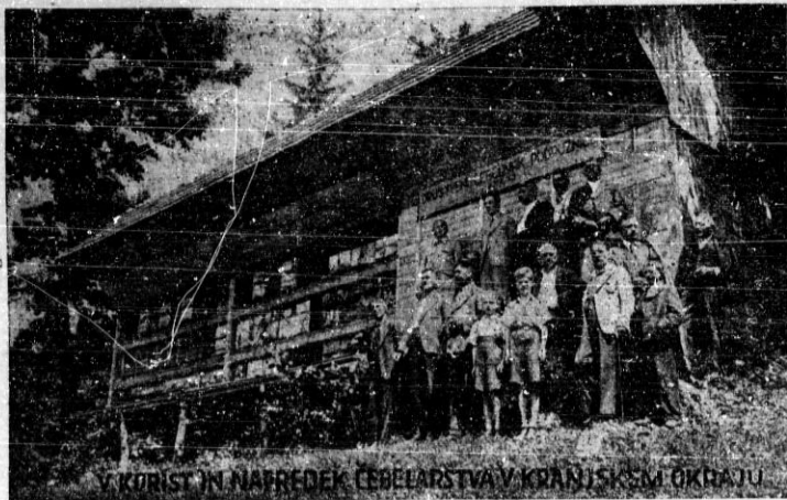
Cebelnjak podružnice S. C. D. v Kranju, ki se nahaja v Bašlu, zgrajen letos spomladi.
