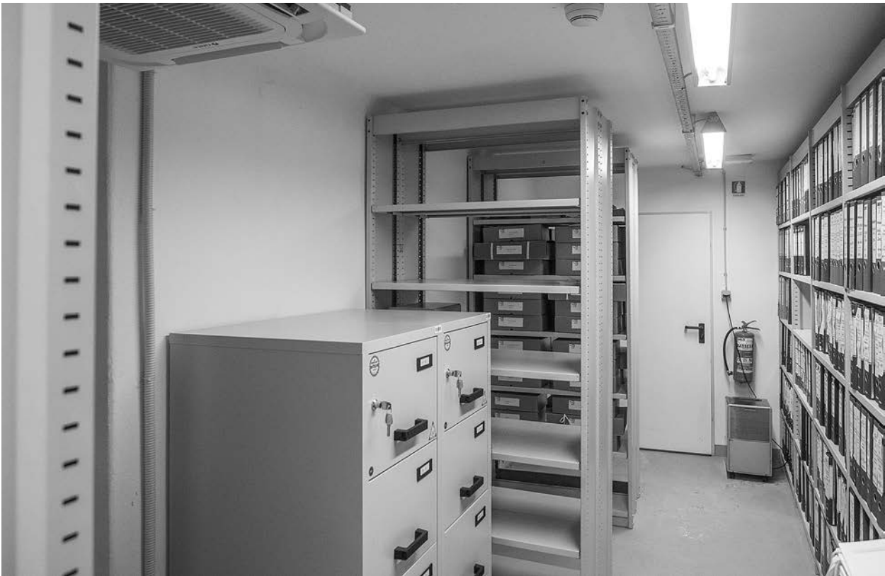
Opremljenost prostora stalne zbirke NUK v kleti Plečnikove stavbe: kovinska oprema, gasilni aparat, razvlažilnik, klimatska naprava in javljalik požara (Foto: Maj Blatnik 2023)
