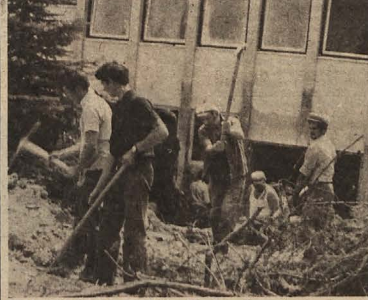
PRIZIDEK JE PRIDOBITEV — Kot kaže današnji posnetek, bodo z deli okoli prizidka metliškega zdravstvenega doma kmalu prenehali. Na sliki: delavci pred novim objektom, ki je za metliško občino velika pridobitev. (Foto: Pezelj)
