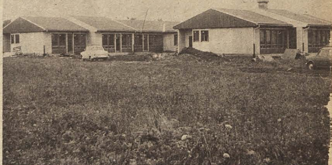
RIBNIČANI DOBE VRTEC – Novi vrtec, ki ga je zgradil mariborski Marles in ki bo odprt že jeser bo za Ribničane ogromna pridobitev. Kot poročamo, bo novi montažni objekt najsodobnejše opremljen in bo zraven oddelka za predšolske otroke in jasli vseboval tudi jedilnico za 120 šolarjev. Z njegovo otvoritvijo bo nekoliko omiljen položaj varstva predšolskih otrok v Ribnici. (Foto: B. Budja)
