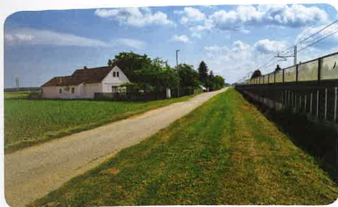
Rekonstrukcija ceste in vodovoda v Cirkovcah od 70 do 74a
