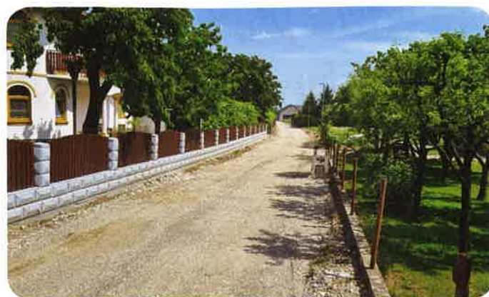
Asfaltiranje ceste v Cirkovcah od 60c do 60j
