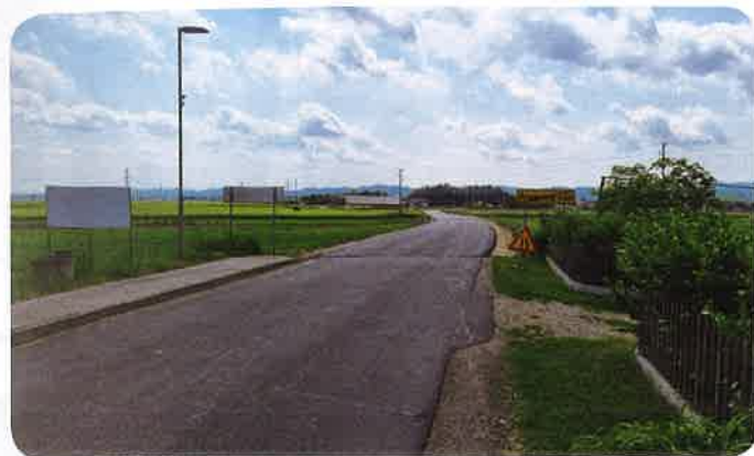
Rekonstrukcija ceste Mihovce–Cirkovce
