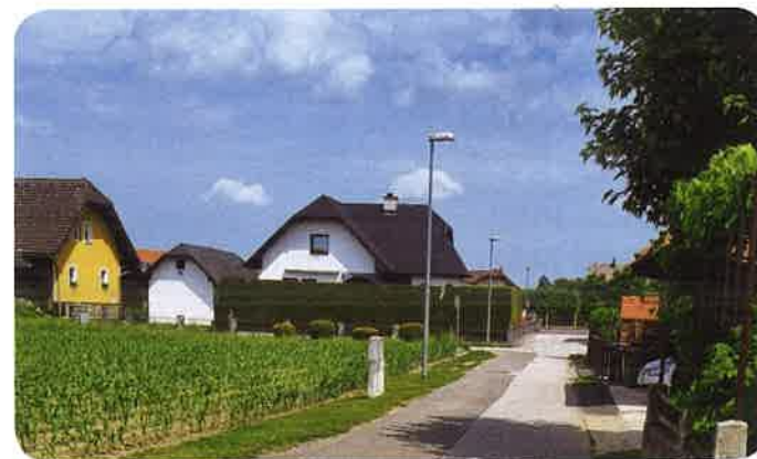
Rekonstrukcija ceste in delno vodovoda v Lovrencu od 77 do 86, do 93
