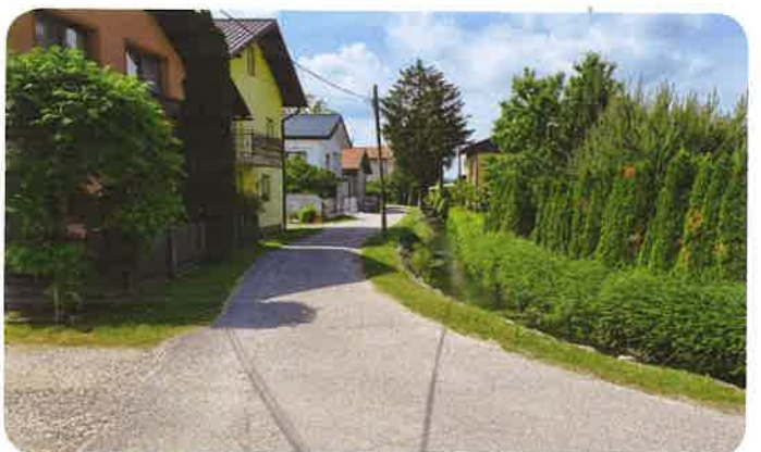
Rekonstrukcija ceste in vodovoda v Šikolah 3, 4, 5, 6
