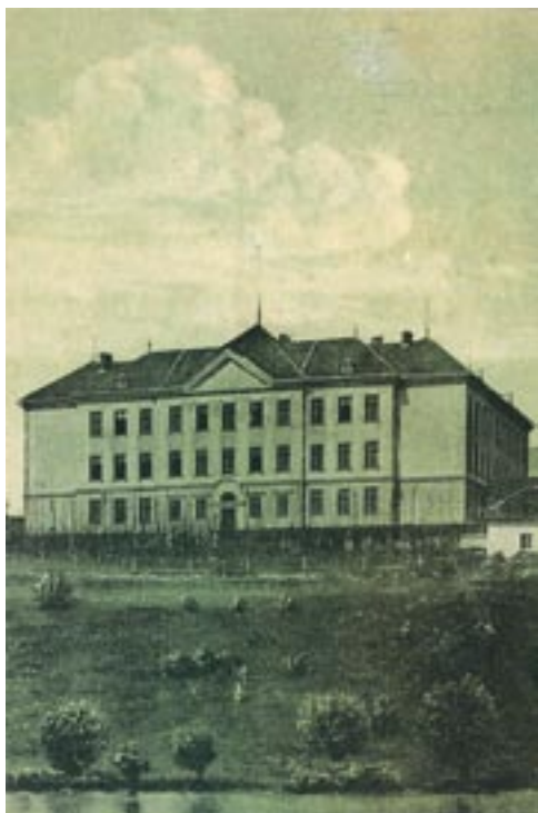
Gimnazijsko poslopje zgrajeno 1912
