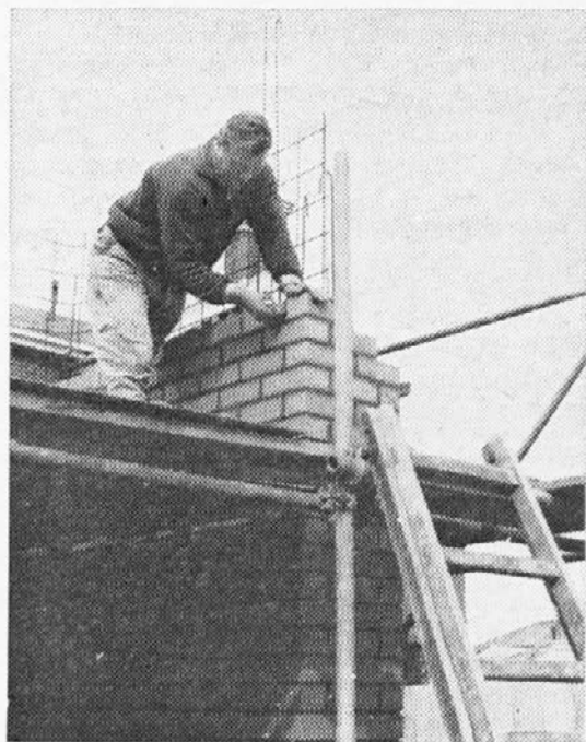
Pred desetimi leti: Zvonik je bil zadnji na vrsti . . . Na sliki je zidar in vodja Alojz Markič, ki ima pri zidavi naše cerkve največ zaslug.
