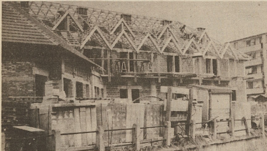
Izgradnja hotela napreduje kljub letošnji ostri zimi po predvidenem načrtu. Delavci delovne organizacije „Ingrad“ pokrivajo streho nad hotelskim delom.
