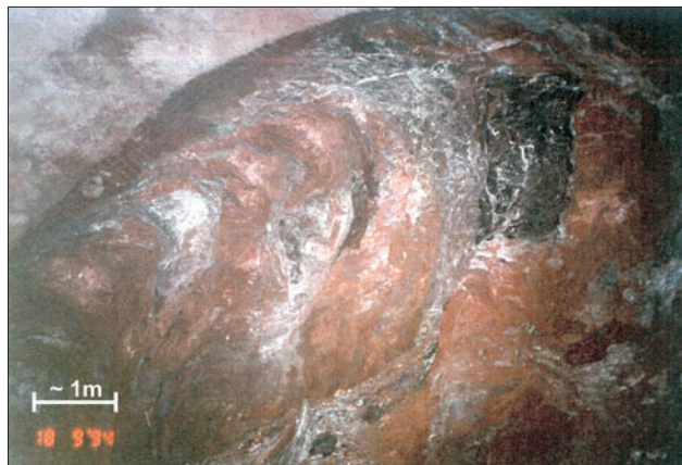
Sl. 2. Subvertikalni tektonski vkleščki werfenskih in karbonsko-permskih plasti v Donački prelomni coni, kalota na stacionaži 29 885 m
