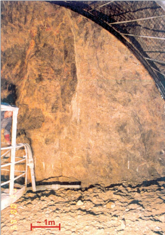
Sl. 4. Zdrobljen dolomit (spodnji trias), kalota na stacionaži 30 065 m
