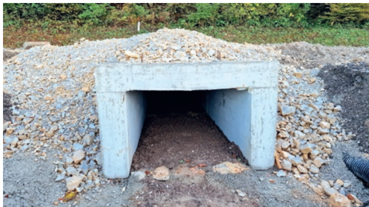
Vgradnja podhodov pri Podkraju je v zaključni fazi.
