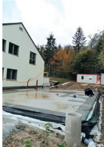
Plošča, na kateri bo stala montažna konstrukcija prizidka.
