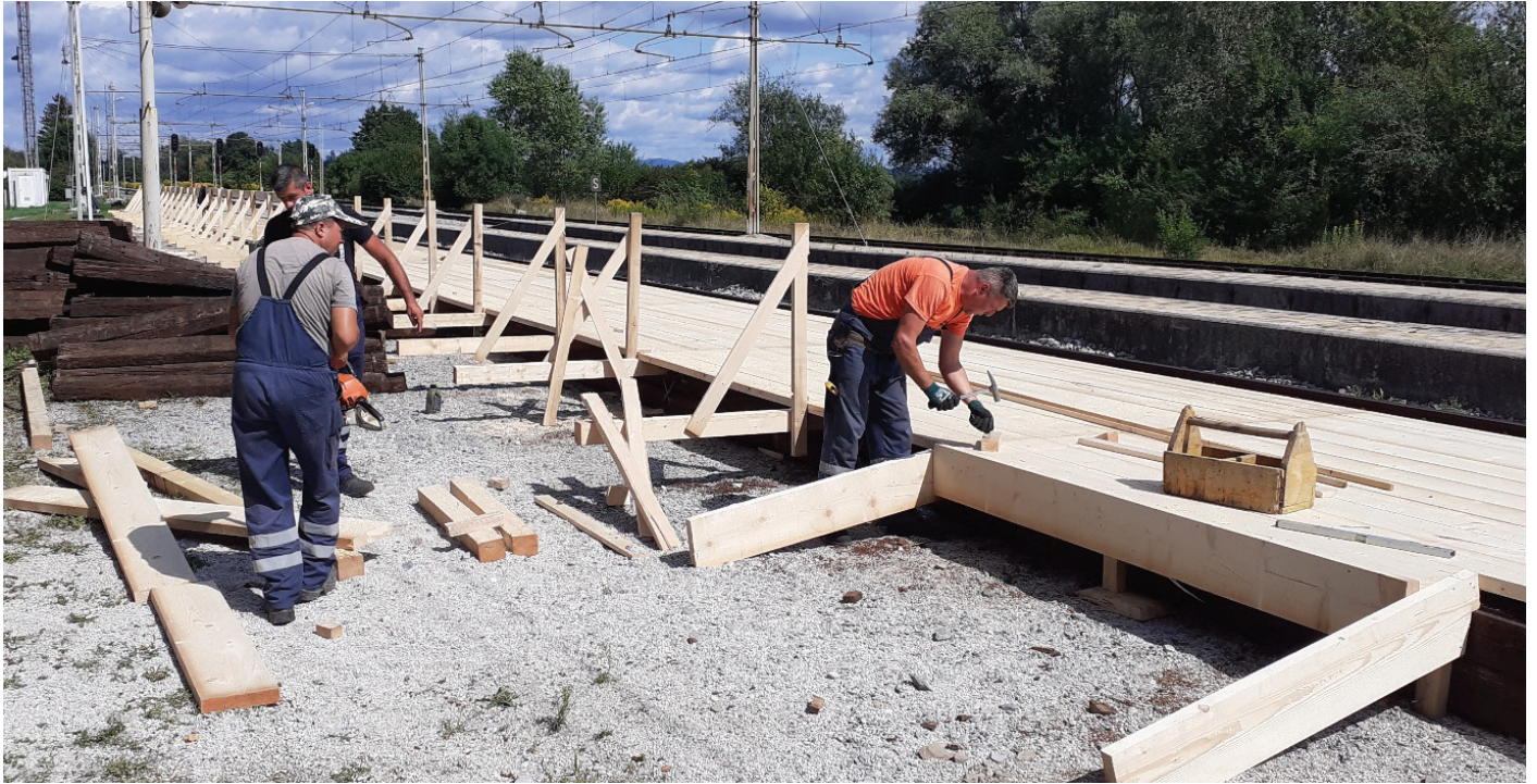
Slika 2. Gradnja začasnega perona na železniški postaji Brezovica – levi tir.
