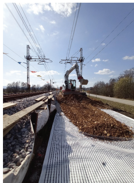
Slika 11. Zasipanje geotekstila in geomreže spodnjega ustroja ob Cesti v Log – desni tir.
