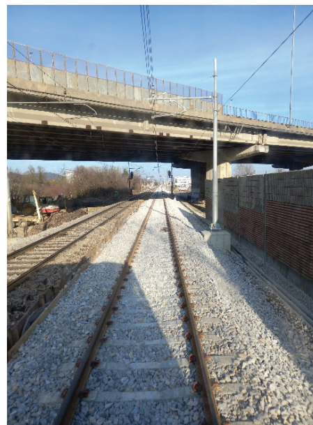
Slika 8. Nadgrajeni levi tir na odseku Ljubljana–Brezovica.
