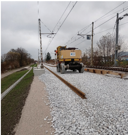
Slika 3. Priprava tirnic na razgrnjeni tolčenec – levi tir.
