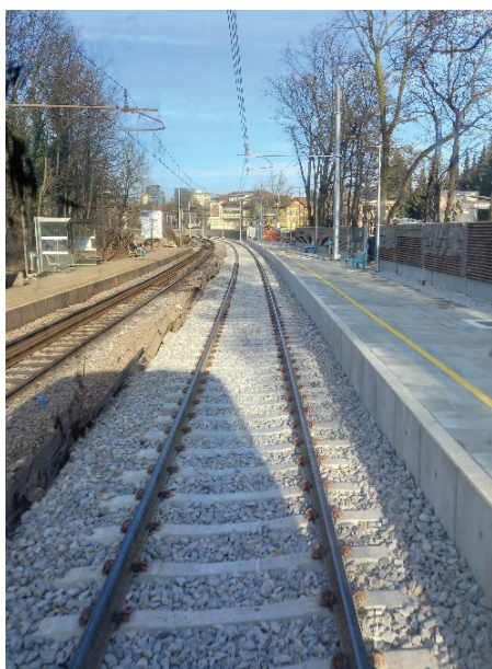
Slika 9. Nadgrajeni levi tir na odseku Ljubljana–Brezovica.
