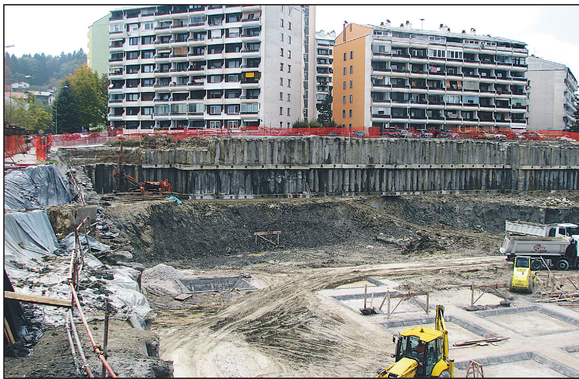
Gradbena jama na Gorici je predolgo odprta. Gradnjo naj bi pospešili že v teh dneh. Če ne bo šlo po načrtih, na občini razmišljajo celo o menjavi izvajalca del.
