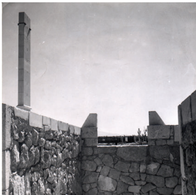
Slika 9: Sklepni pogled proti vhodni ploščadi skozi kamniti okvir v zidu.
