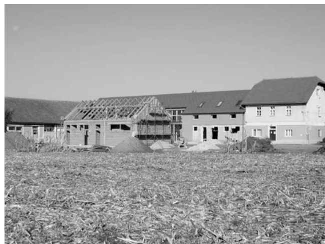
Gradnja kampa z infrastrukturo in promocijsko-informacijskega centra. Foto: Janez Krnc, Veržej, 26. 7. 2011
