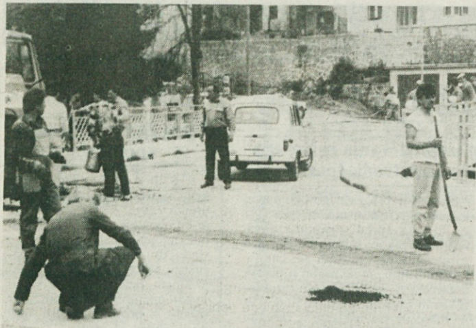
OBNOVLJENA MOSTOVA - Pred kratkim so obnovili hudo načeto cestišče na spodnjih dveh mostovih črnomaškega tromostovja. Gre za mostova čez Dobljico in Lahinjo ob sotočju teh rek. Delavci so se pri obnovi potrudili in delo hitro opravili, tako da ni bilo daljših in hujskih zastojev. Ob tem so obnovili tudi mostni ograji. (Foto: A. B.)
