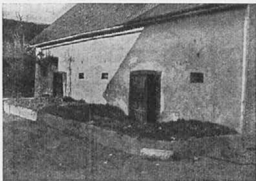
Slika 3. Pravilno zgrajeno gnojišče z gnojnično jamo. Odprtina za črpalko mora biti izven gnojišča. Streha je oskrbljena z žlebom, da se kapnica ne steka na gnojišče. Zid hleva mora biti izoliran.
