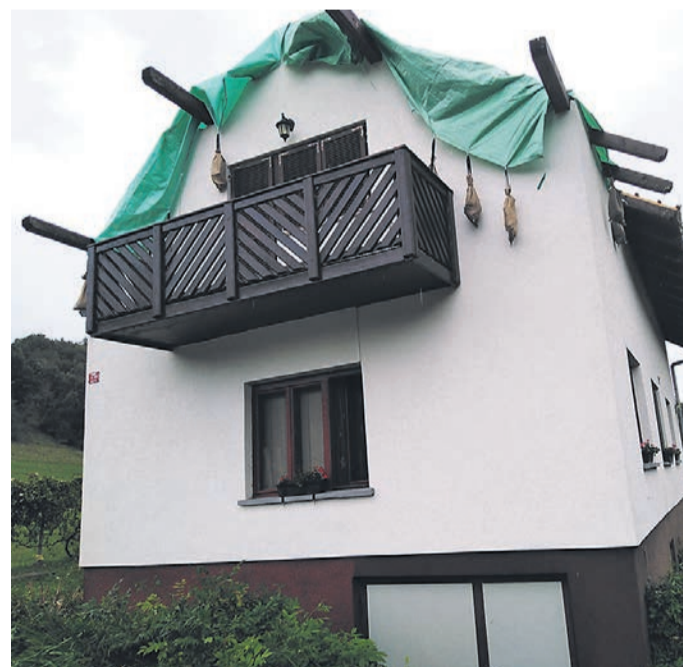
Od strehe z zračnim mostom, izolacijo, strešno opeko ostalo bore malo.
