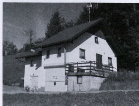
Prenovljena streha gasilskega doma v Zavratacu. Foto Jože Lazar.
