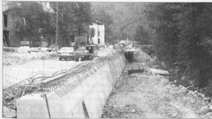
Lavori di sistemazione stradale (foto d'archivio)
