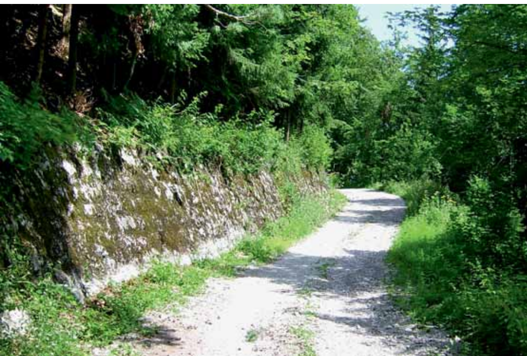
Gradnja obrambne linije nam je zapustila mnogo kvalitetno grajenih gozdnih cest; odsek Podpulfrca–Zapreval.
