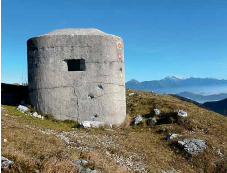
Ostanki bunkerjev Rupnikove linije na vrhu Blegoša FOTO: LADO BRIŠAR
