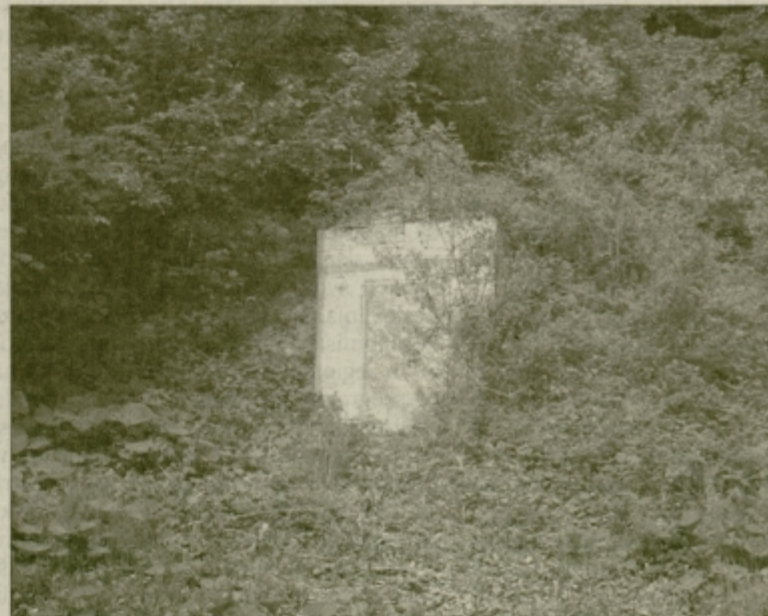
Rezervoar za vodovod bodo morali ob priključitvi novih odjemalcev najverjetneje povečati.
