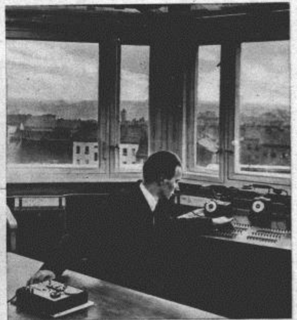
Die erste Lichtwarte wurde in Berlin geschaffen mit dem Zweck, die Beleuchtung der Weltstadt den jeweiligen Lichtverhältnissen anzupassen. Die in 50 Meter Höhe errichtete und mit feinen Meßapparaten ausgerüstete Station arbeitet in den Stunden um Sonnenuntergang und -aufgang und sorgt für genügende, aber nicht übertriebene Straßenbeleuchtung Atlante
