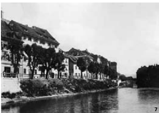
Sl. 4: Gradnja mostu na Gruberjevem kanalu (zadaj je železniški most). Sl. 5: Šentjakovski most. Sl. 6: Šentjakovski most in perice. Sl. 7: Nabrežje, pred posegi Plečnika in Vožličev.
